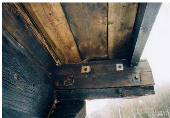
Bilete 2.25: Forsterkning av råteskadd skakestokk (overmann til svala), Holslopte, Bykle.
