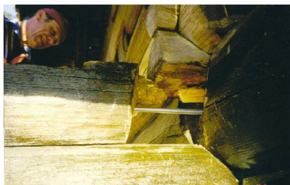
Bilete 2.6: Reparasjon av skade på skakestokk, Bakken, Bjørgum, Hylestad. Gjengestaget er sett inn i skakestokken
