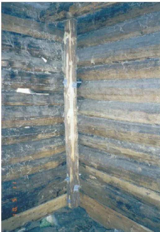
Bilete 2.12: Dobbel strekkfisk sett innanfrå på løa på Bakken, Bjørgum.
