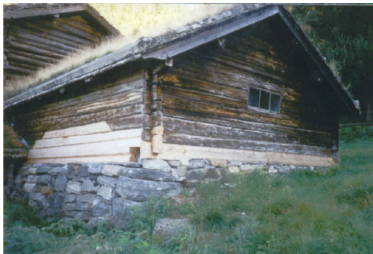
Bilete 2.16: Antikvariske prinsipp brukt til å restaurere fjaset på Rygnestadtunet.
