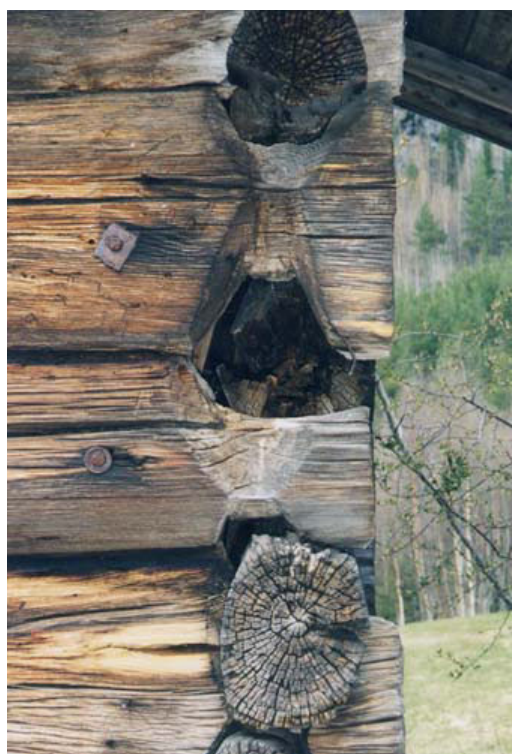
Bilete 2.10: Innvendig strekkfisk sett utanfrå på lopte på Flateland.
