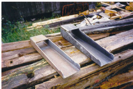
Bilete 2.36: Jern brukt til å forlengje bjelkane, Muggslopte, Innestog Byklum, Bykle.
