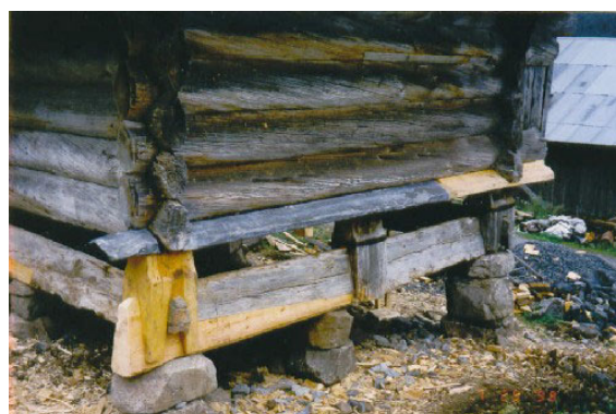
Bilete 2.31: Brukar blyplater til å sikre den originale delen som er att av musesyddi på Muggslopte, Innestog Byklum, Bykle.
