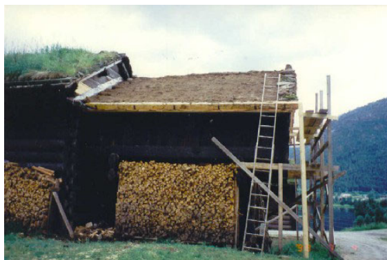
Bilete 2.34: Bruk av blyplater til sikring av overgong frå tak til treverk, Bakken, Bjørgum, Hylestad.
