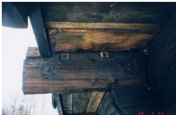
Bilete 2.24: Forsterkning av råteskadd skakestokk (overmann til svala), Holslopte, Bykle.
