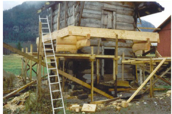
Bilete 2.5: Alt ferdig montera med svaesydd (tilemor) på lopt, Dale, Valle.
