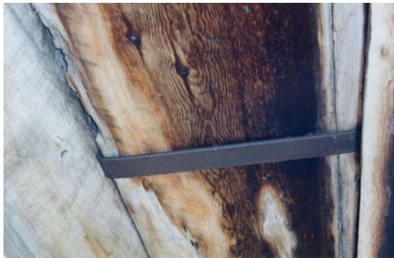
Bilete 2.20: Sikring av tileplank i loptssvala, Rygnestadtunet, Valle.
