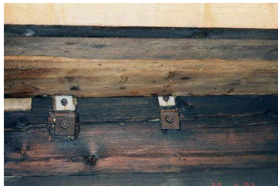
Bilete 2.26: Forsterkning av råteskadd skakestokk (overmann til svala), Holslopte, Bykle.
