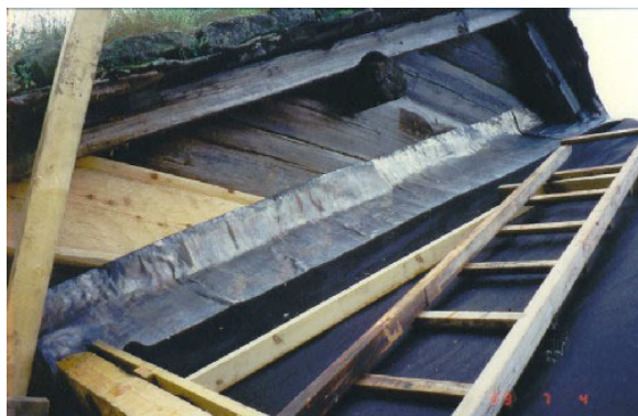
Bilete 2.33: Bruk av blyplater til sikring av overgong frå tak til treverk, Bakken, Bjørgum, Hylestad.
