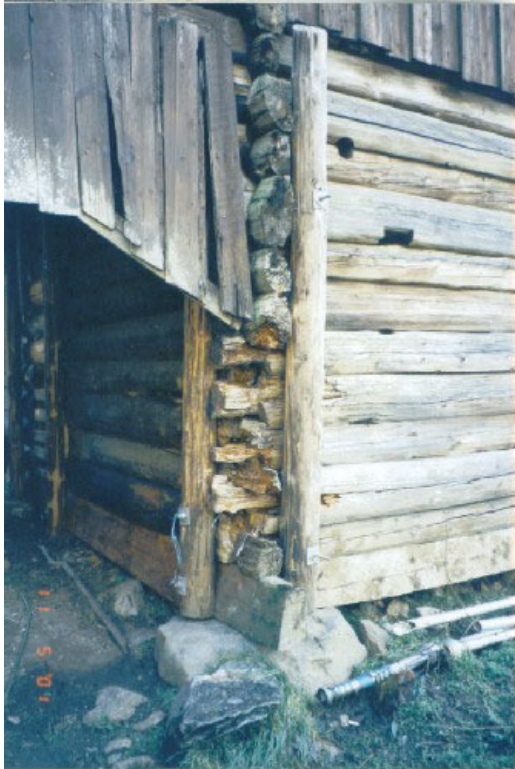
Bilete 2.11: Dobbel strekkfisk sett utanfrå på løa på Bakken, Bjørgum.
