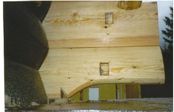
Bilete 2.4: Ferdig montera skakestokk på lopt, Dale, Valle.
