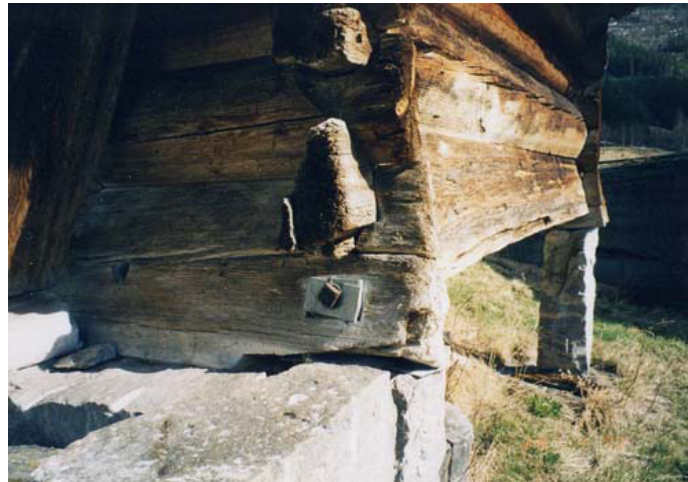
Bilete 2.2: Sikring av utpressa sydd med kort gjengestag, Nistog Rygnestad, Valle.
