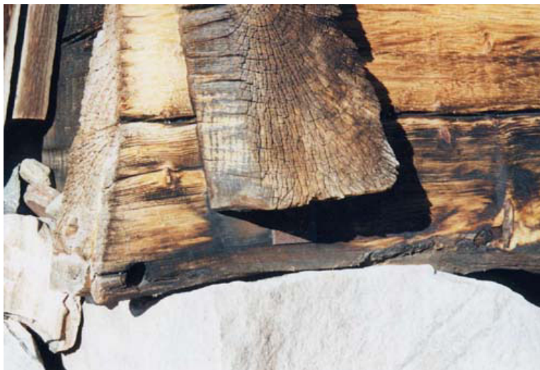
Bilete 3.1: Sikring av utpressa sydd, lopt, Rygnestadtunet, Valle.
