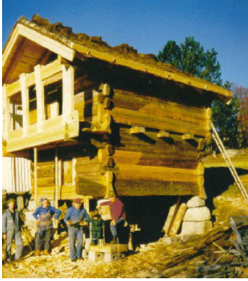
Bilete 2.19: Brottveitslopte restaurera etter antikvariske prinsipp, Valle.
