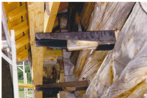
Bilete 2.35: Sikring av fundamenta i svala med å forlengje bjelkane, Muggslopte, Innestog Byklum, Bykle.
