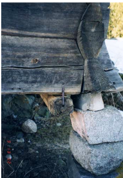
Bilete 2.17: Halgreip brukt til å binde tvifara (bjelkar) til sydd, lopte, Tveitetunet, Valle.
