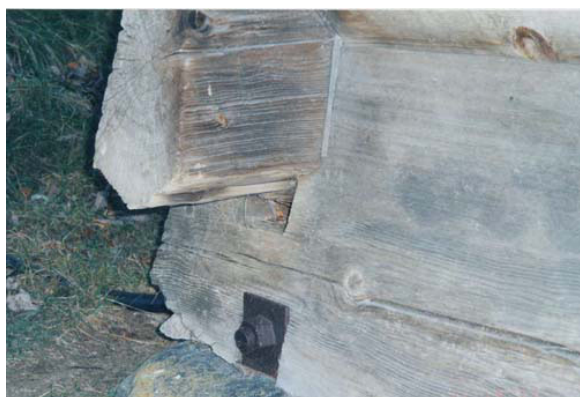
Bilete 2.1: Sikring av utpressa sydd med langt gjengestag, lopt, Rygnestadtunet, Valle.
