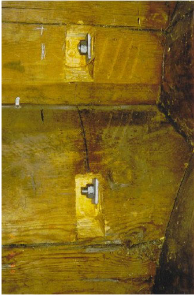
Bilete 2.7: Samanpressing med gjengestag, Bakken, Bjørgum, Hylestad.
