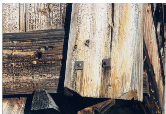
Bilete 2.27: Sikring av hjørnestolpar, loptssval, Rygnestadtunet, Valle.
