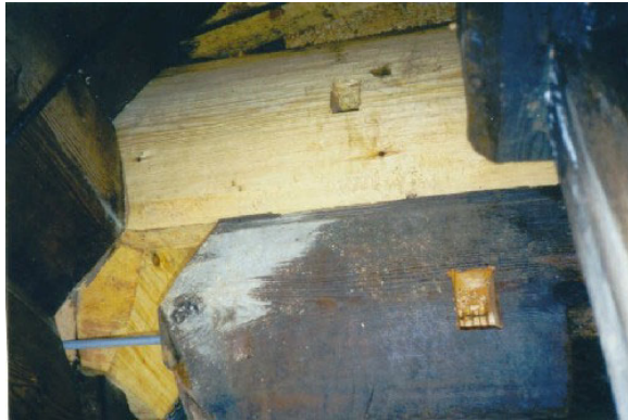
Bilete 2.3: Bruk av gjengestag til å restaurere ustikkande sval skakestokk (overmann/undermann) på lopt, Dale, Valle.
